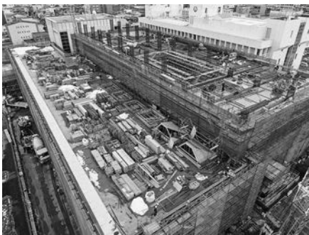
新庁舎建設工事の様子 (R2.12)
